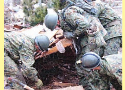
東日本大震災復旧・復興作業
