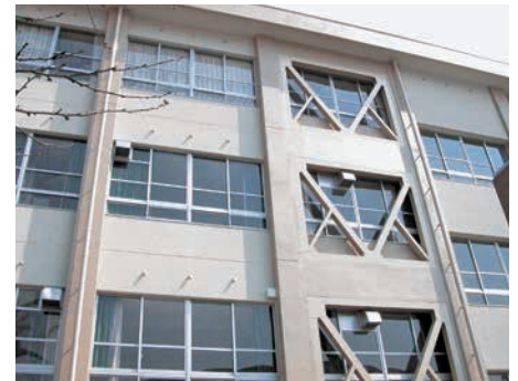
地震から学校を守ります。(耐震工事)
